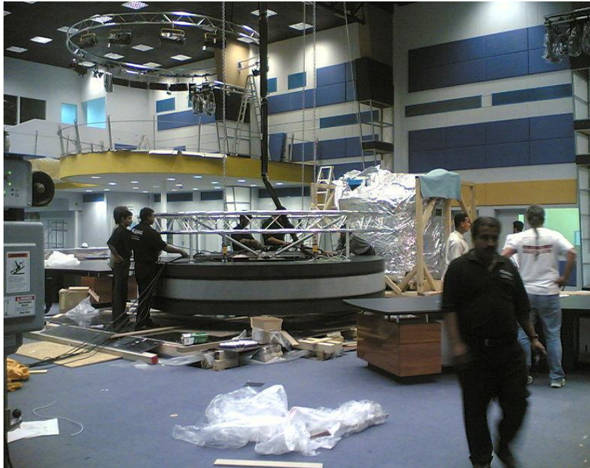
L'installation de la grille de lumières sur un plateau de télévision
