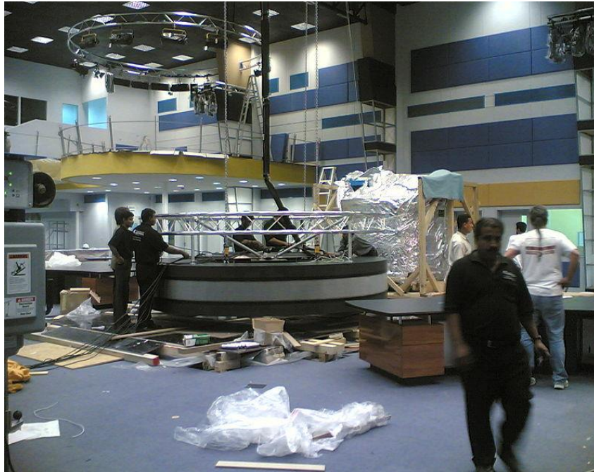
Instalarea grilei de lumini într-un platou de televiziune
