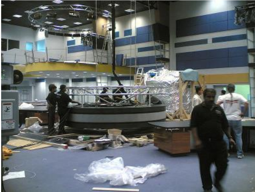
Instalarea grilei de lumini într-un platou de televiziune – foto – Adrian Zăvoianu
